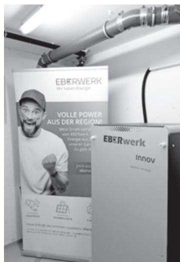
Die Anlage mit einer Leistung von 100 Kilowatt liefert eine Strommenge von etwa 95.000 Kilowattstunden pro Jahr.
