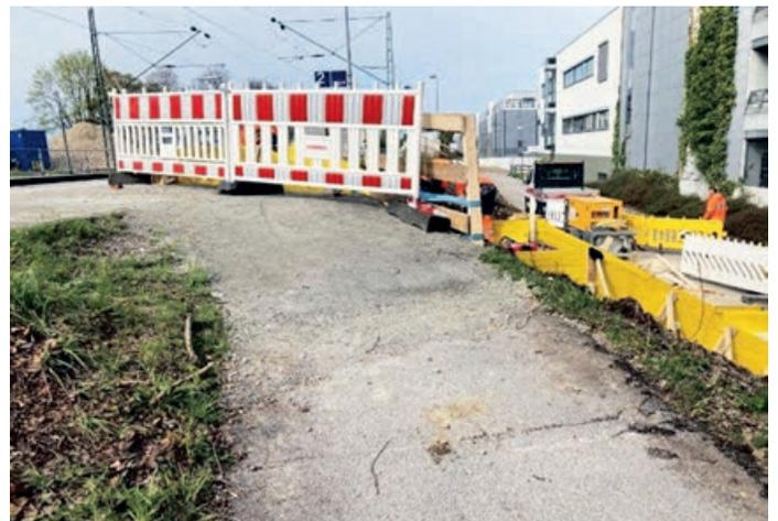
(so) Die bestehende, nicht barrierefreie Nord-Ost-Rampe ist wieder benutzbar. Der Bauzaun steht zur Abgrenzung der Baustelle an der Treppe. Dort werden noch Betonarbeiten ausgeführt. Der Holzzaun dient als Absturzsicherung in Richtung der Böschung.
