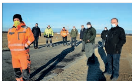
Dezember: Die Straßen im Neubaugebiet Lerchenwinkel sind fertig. Die Hochbaumaßnahmen beginnen 2021.
