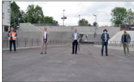
April: Die Bahnüberführung an der S-Bahn-Station Poing verbindet seit April Poing-Süd und Poing-Nord.
