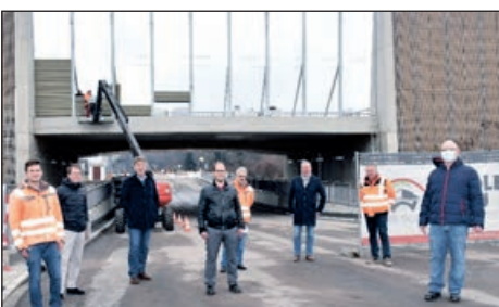
Dezember: Die Bahnunterführung „Am Hanselbrunn“ wird offiziell für den Verkehr freigegeben.
