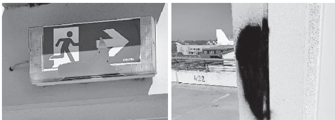
Beschädigte Fluchtweg-Leuchte
