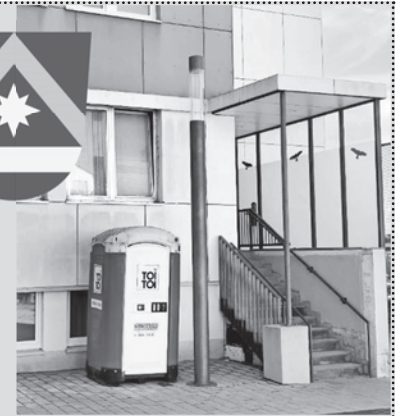
Wegen Bauarbeiten im Rathaus temporärer Seiteneingang.
