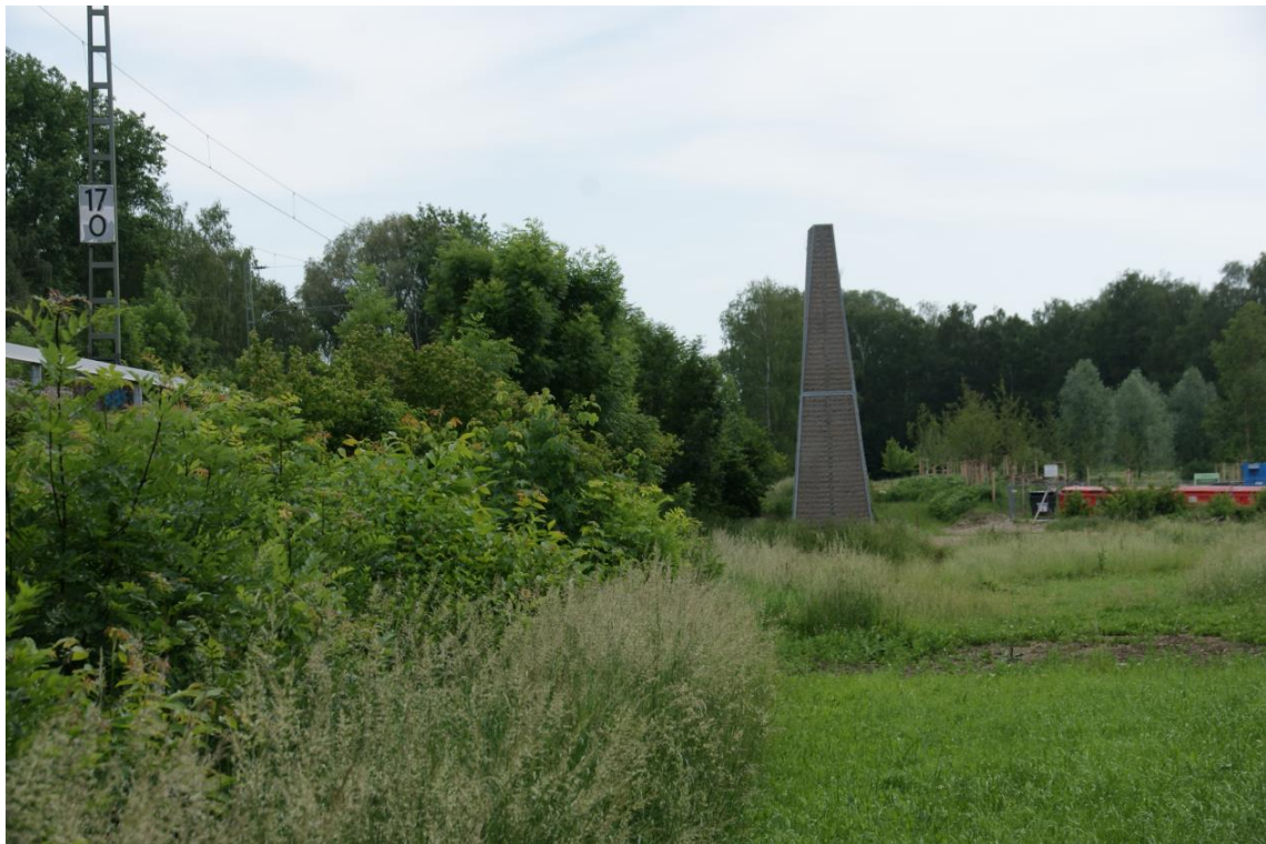
Abbildung 12: Östlich angrenzender Bahndamm mit Lärmschutzwand
