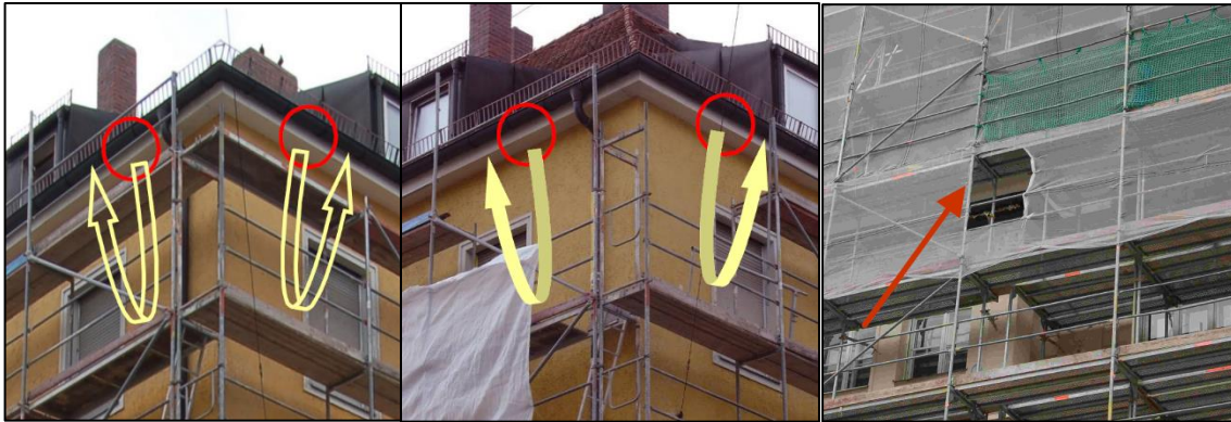
Abbildung 9: Korrekte Einrüstung und Öffnung der Staubnetze an Gebäuden mit Mauersegler-Nistplätzen. links: Ausflug versperrt durch Laufbahn und Handlauf; Mitte: Geöffnetes Gerüst ohne Laufbahn und Handlauf unter den Mauersegler-Nistplätzen, rechts: geöffnetes Staubnetz im Bereich der Nistplätze für Mauersegler und Sperlinge; rote Kreise bzw. Pfeile: Nistplätze; gelbe Pfeile: Ein- bzw. Ausflug der Vögel (LBV 2011)
