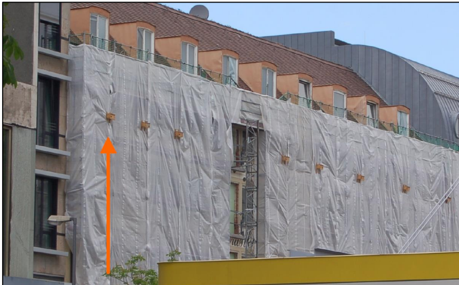
Abbildung 16: Ersatznistkästen für Mauersegler und Sperlinge (nicht dargestellt) außen am Bagerüst (LBV o.A.)
