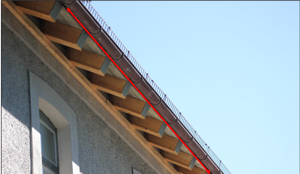
Abbildung 3: Nistplatzbereiche (roter Pfeil) von Mauerseglern und Sperlingen im Dachbereich des Bahnhofsgebäudes in der Gemeinde Poing (Mühl 12.06.2020)
