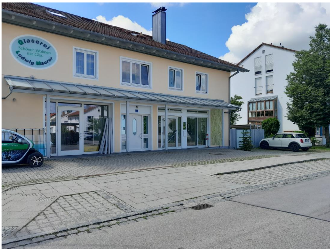
Abb. 3 Ansicht des Westteils des Grundstücks FI.Nr. 408/6 von der Wittelsbacherstraße.
