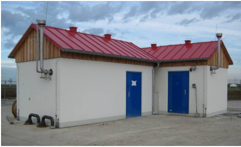
Th1 Brunnenbauwerk und Betriebsgebäude
