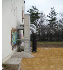
Heizzentrale Eintritt Thermalwasserleitung
