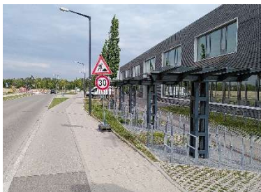
Grundschule Am Bergfeld
