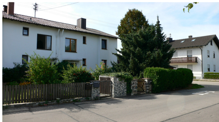
Abbildung 6: Römerstraße, Höhe Keltenstraße, Blick nach Norden (BILDNACHWEIS: BAURÄUME, MÜNCHEN)
